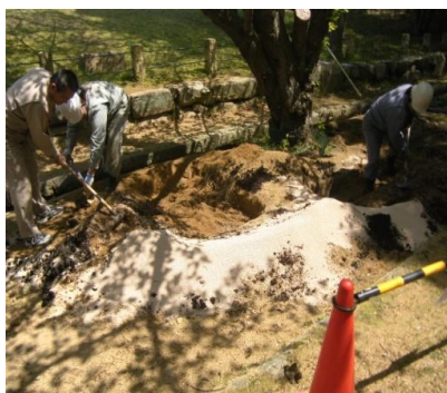
改良材充填状況
